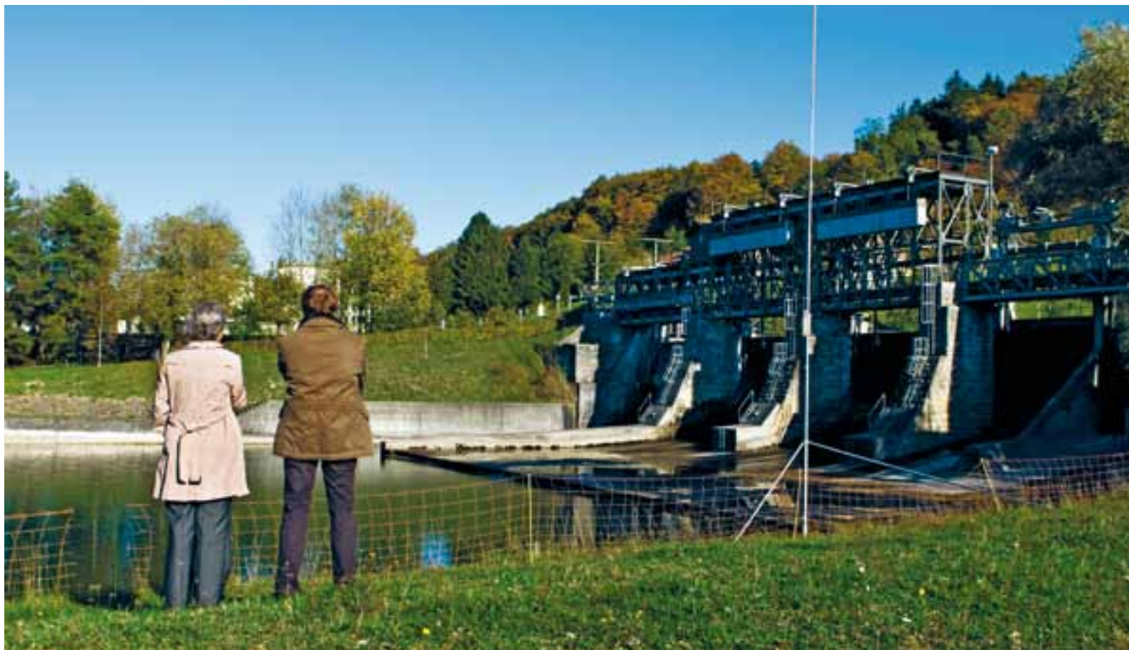
Rendez-vous local sur le canal principal d'Hagneck: Barbara Schwickert, directrice biennoise de l'énergie, et Thomas Richli, chef de projet pour la CELBI, visitent le futur chantier de la nouvelle centrale. À droite, un gabarit marque l'emplacement du nouveau barrage.
